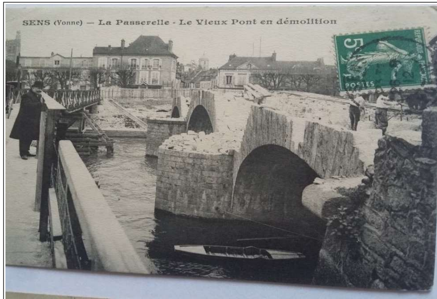
La passerelle – Le vieux pont en démolition © Coll. Alain Guyader
