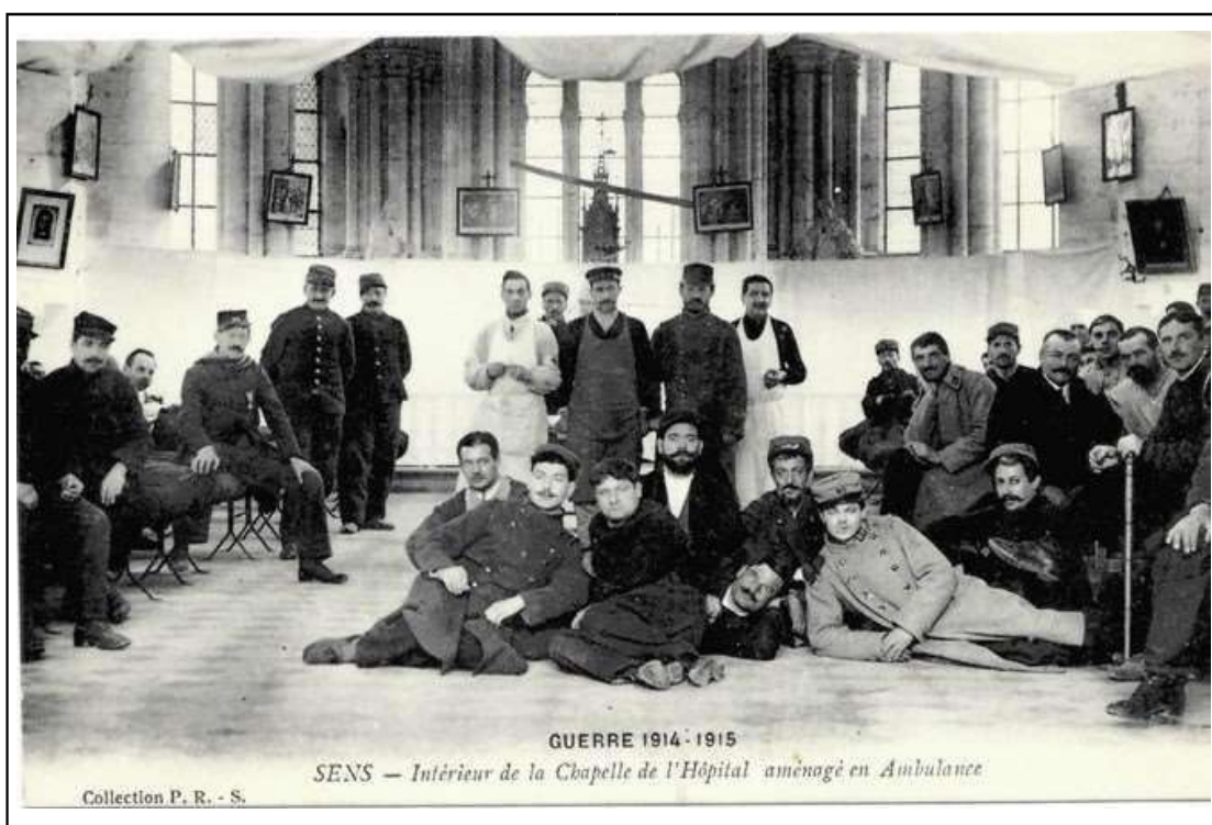
Intérieur de la Chapelle de l'Hôpital © Coll. Pierre Gié
